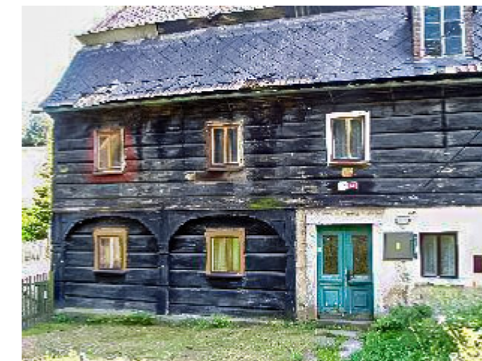
Brtníky č. ev. 69 - Pohled na objekt ze severu (Zdroj: TUR Šluknovsko, 2003)
