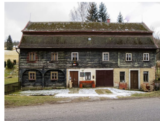
Brtníky č. ev. 69 - Pohled na objekt ze severu (Zdroj: S. Šulcová, 2018)
