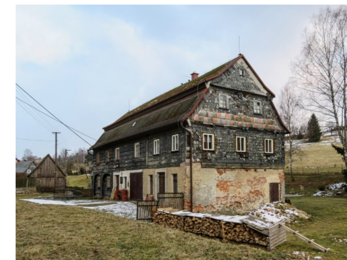
Brtníky č. ev. 69 - Pohled na objekt ze severozápadu (Zdroj: S. Šulcová, 2018)
