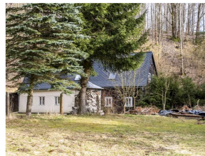
Brtníky č. ev. 70 - Pohled na objekt ze severu (Zdroj: S. Šulcová, 2024)
