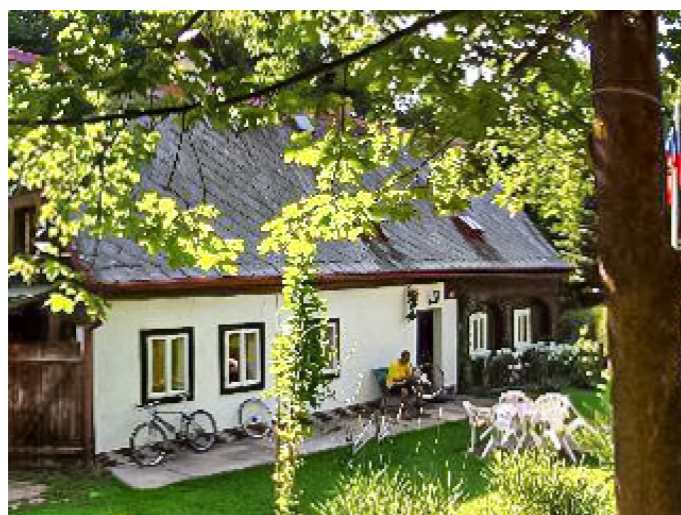
Brtníky č. ev. 70 - Pohled na objekt ze severu (Zdroj: TUR Šluknovsko, 2003)
