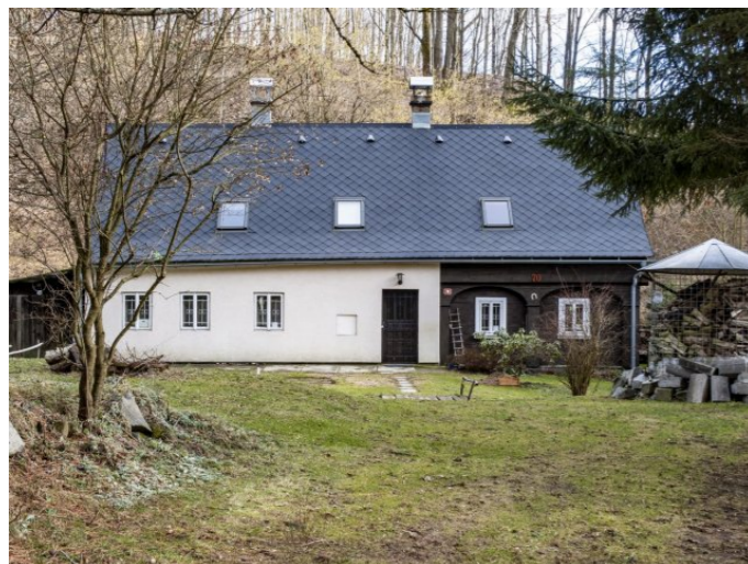
Brtníky č. ev. 70 - Pohled na objekt ze severu (Zdroj: S. Šulcová, 2024)
