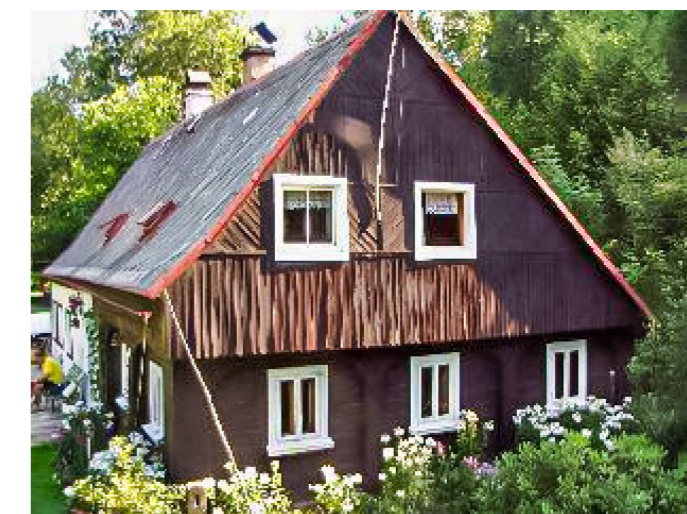
Brtníky č. ev. 70 - Pohled na objekt z jihozápadu (Zdroj: TUR Šluknovsko, 2003)
