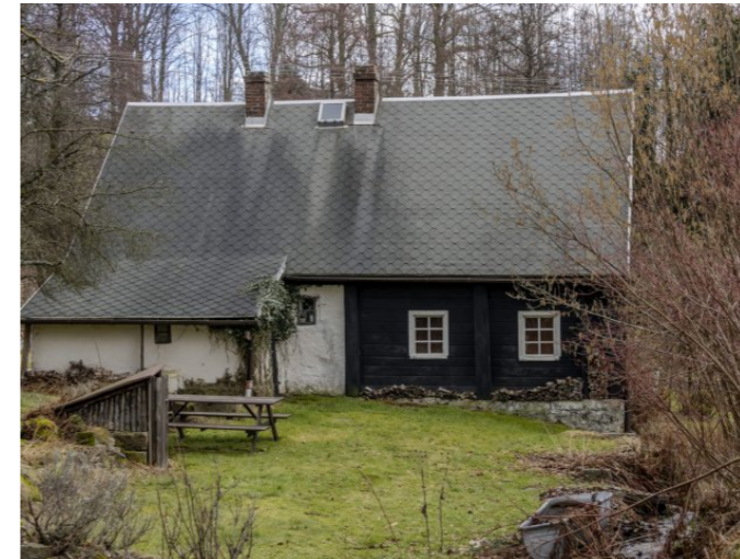
Brtníky č. ev. 71 - Pohled na objekt ze severozápadu (Zdroj: S. Šulcová, 2024)
