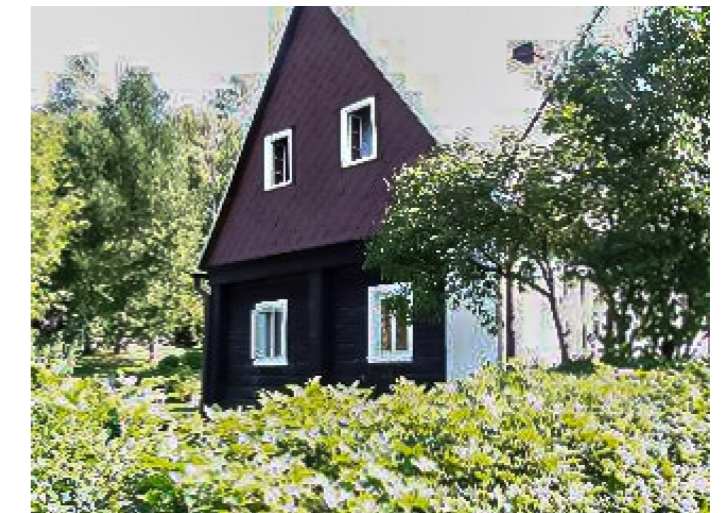
Brtníky č. ev. 71 - Pohled na objekt ze severu (Zdroj: TUR Šluknovsko, 2003)
