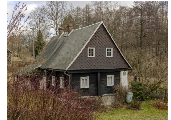
Brtníky č. ev. 71 - Pohled na objekt ze západu (Zdroj: S. Šulcová, 2024)
