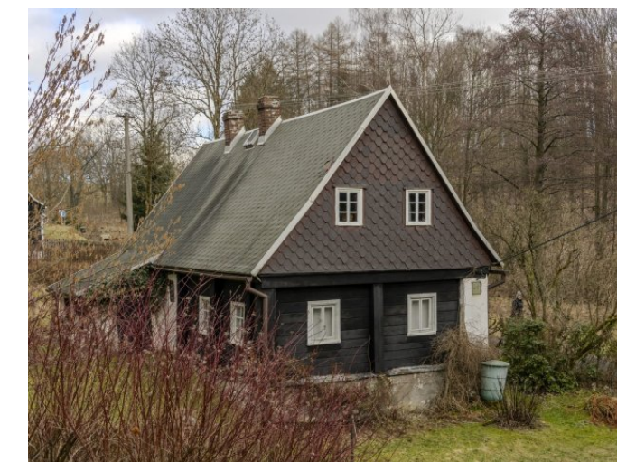
Brtníky č. ev. 71 - Pohled na objekt ze západu (Zdroj: S. Šulcová, 2024)
