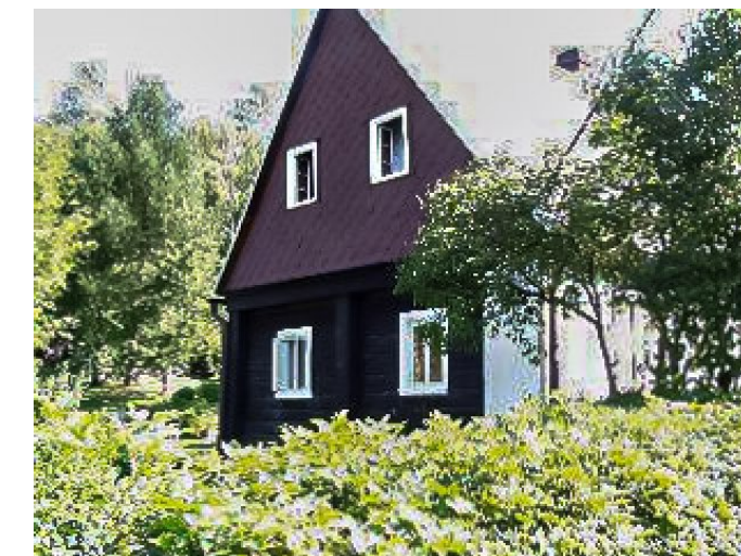
Brtníky č. ev. 71 - Pohled na objekt ze severu (Zdroj: TUR Šluknovsko, 2003)
