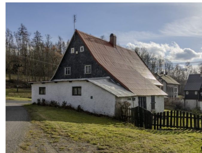
Brtníky č. ev. 79 - Pohled na objekt ze severu (Zdroj: S. Šulcová, 2024)
