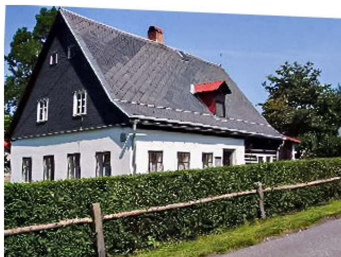
Brtníky č. ev. 79 - Pohled na objekt z jihu (Zdroj: TUR Šluknovsko, 2003)
