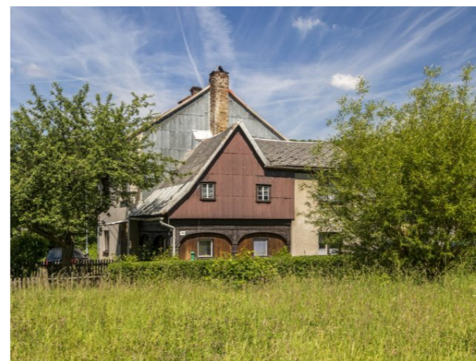
Mikulášovice č. p. 104 - Pohled na objekt z jihovýchodu (Zdroj: S. Šulcová, 2017)
