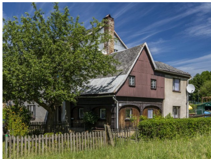
Mikulášovice č. p. 104 - Pohled na objekt z jihu (Zdroj: S. Šulcová, 2017)
