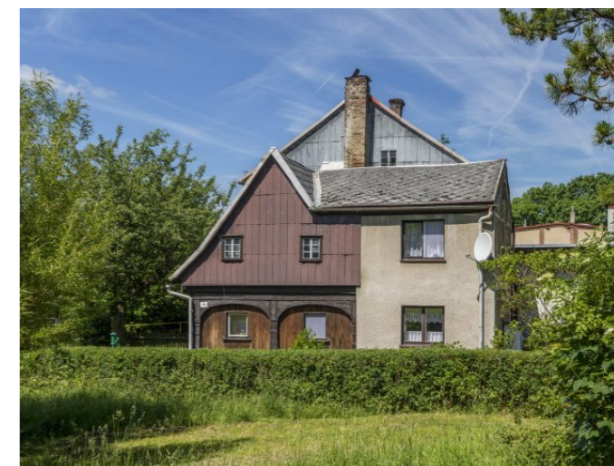
Mikulášovice č. p. 104 - Pohled na objekt z východu (Zdroj: S. Šulcová, 2017)
