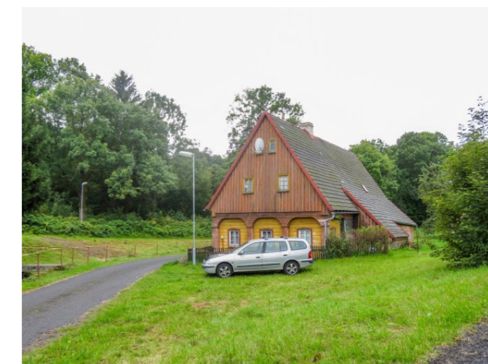
Mikulášovice č. p. 126 - Pohled na objekt ze severovýchodu (Zdroj: S. Šulcová, 2017)
