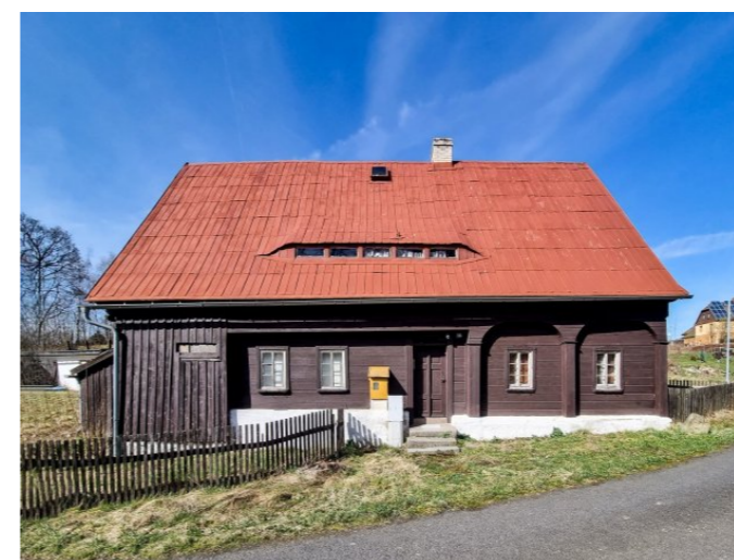
Mikulášovice č. p. 126 - Pohled na objekt z jihu (Zdroj: S. Šulcová, 2024)
