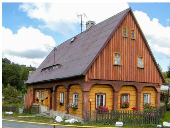
Mikulášovice č. p. 126 - Pohled na objekt z východu (Zdroj: TUR Šluknovsko, 2003)
