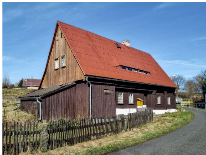
Mikulášovice č. p. 126 - Pohled na objekt z jihozápadu (Zdroj: S. Šulcová, 2024)
