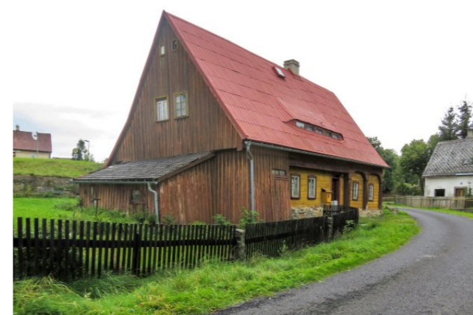
Mikulášovice č. p. 126 - Pohled na objekt z jihozápadu (Zdroj: S. Šulcová, 2017)
