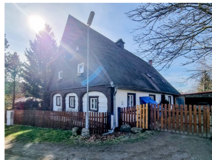
Mikulášovice č. p. 139 - Pohled na objekt ze severovýchodu (Zdroj: S. Šulcová, 2024)
