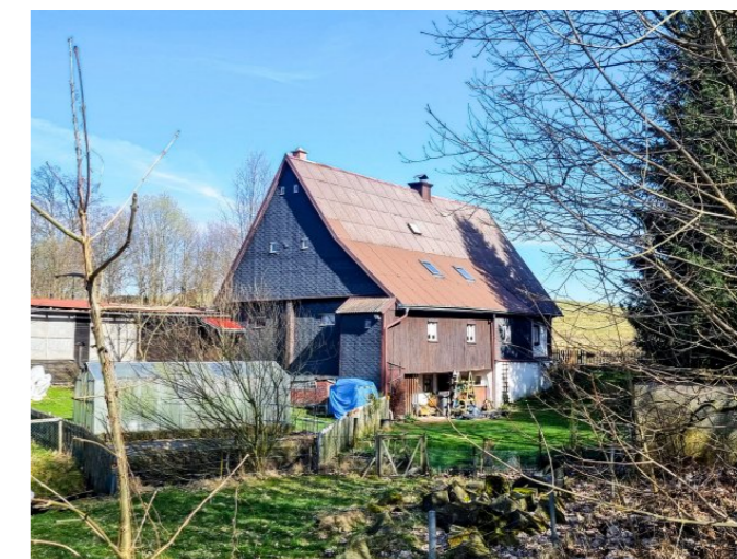
Mikulášovice č. p. 139 - Pohled na objekt z jihu (Zdroj: S. Šulcová, 2024)
