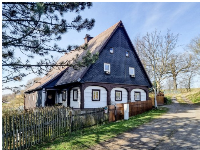
Mikulášovice č. p. 139 - Pohled na objekt z jihovýchodu (Zdroj: S. Šulcová, 2024)
