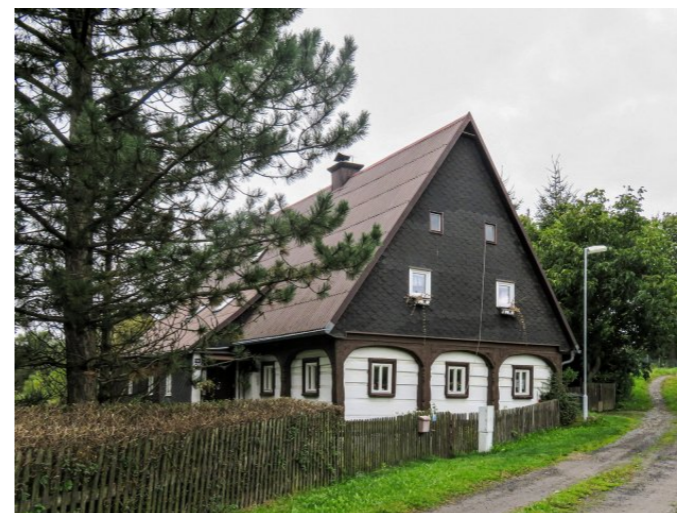
Mikulášovice č. p. 139 - Pohled na objekt z jihovýchodu (Zdroj: S. Šulcová, 2017)
