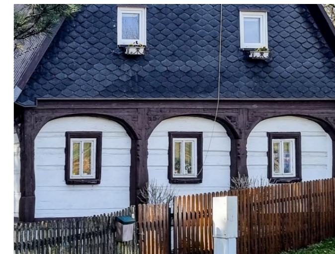
Mikulášovice č. p. 139 - Pohled na podstávková pole (Zdroj: S. Šulcová, 2024)
