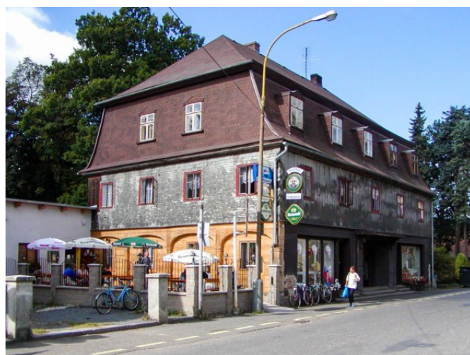
Mikulášovice č. p. 16 - Pohled na objekt ze severovýchodu (Zdroj: TUR Šluknovsko, 2003)
