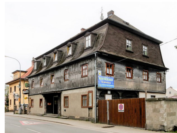
Mikulášovice č. p. 16 - Pohled na objekt ze severozápadu (Zdroj: S. Šulcová, 2024)
