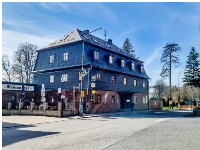
Mikulášovice č. p. 16 - Pohled na objekt ze severovýchodu (Zdroj: S. Šulcová, 2024)
