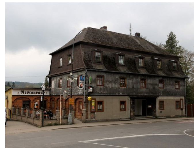
Mikulášovice č. p. 16 - Pohled na objekt ze severovýchodu (Zdroj: S. Šulcová, 2017)
