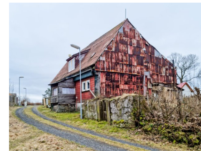
Mikulášovice č. p. 212 - Pohled na objekt ze severozápadu (Zdroj: S. Šulcová, 2024)
