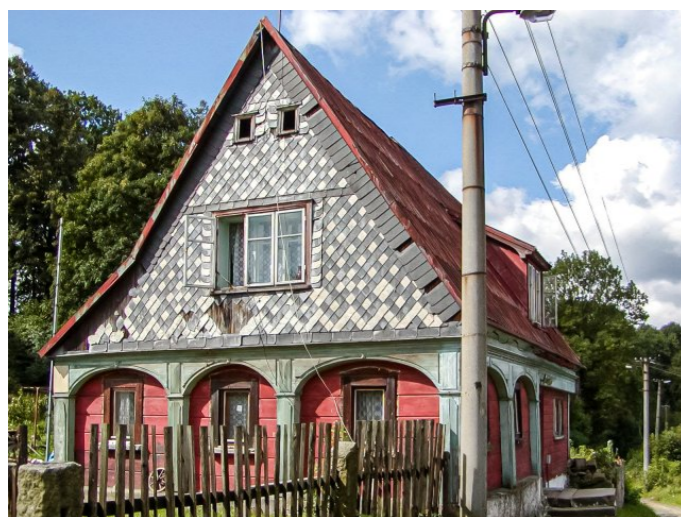
Mikulášovice č. p. 212 - Pohled na objekt ze severovýchodu (Zdroj: TUR Šluknovsko, 2003)
