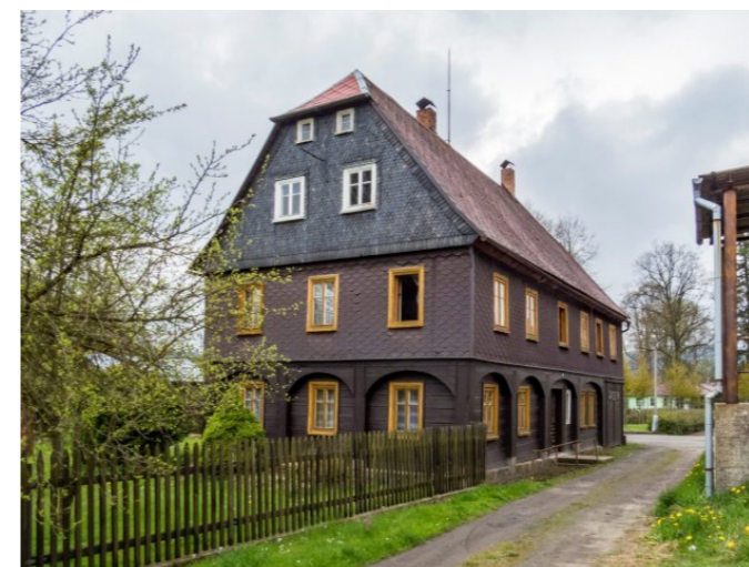
Mikulášovice č. p. 24 - Pohled na objekt z východu (Zdroj: S. Šulcová, 2017)
