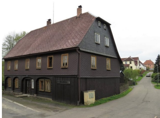
Mikulášovice č. p. 24 - Pohled na objekt ze severozápadu (Zdroj: S. Šulcová, 2017)
