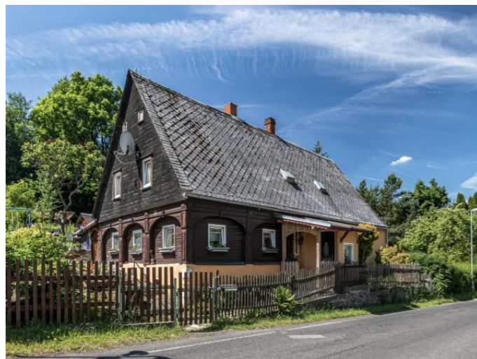
Mikulášovice č. p. 262 - Pohled na objekt ze severovýchodu (Zdroj: S. Šulcová, 2017)
