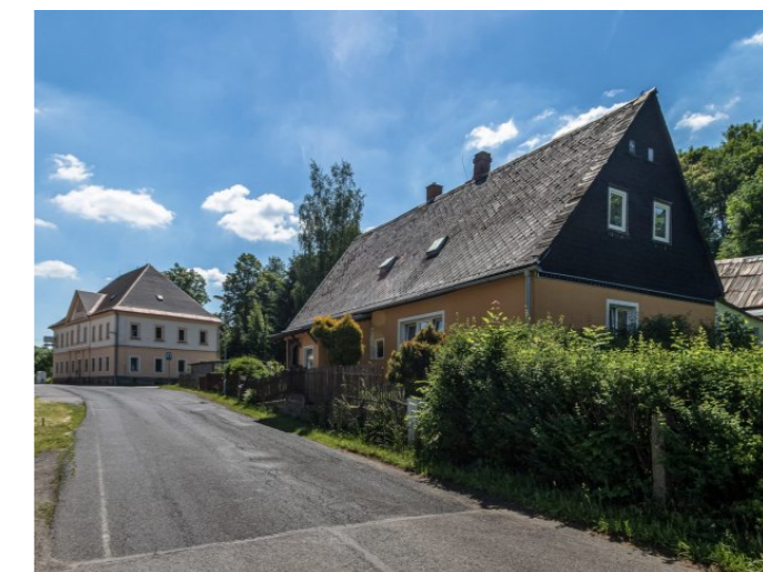
Mikulášovice č. p. 262 - Pohled na objekt ze severozápadu (Zdroj: S. Šulcová, 2017)
