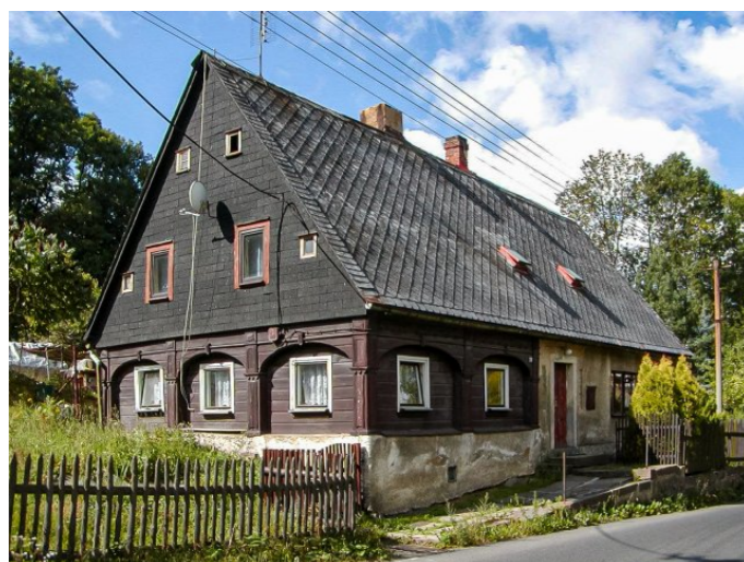
Mikulášovice č. p. 262 - Pohled na objekt ze severovýchodu (Zdroj: TUR Šluknovsko, 2003)
