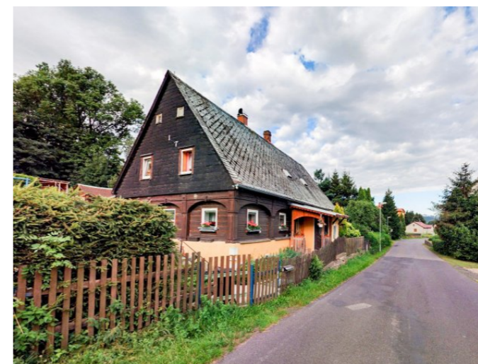
Mikulášovice č. p. 262 - Pohled na objekt ze severovýchodu (Zdroj: Mapy.cz, 2021)
