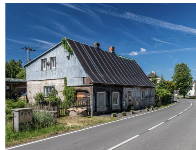
Mikulášovice č. p. 285 - Pohled na objekt ze severovýchodu (Zdroj: S. Šulcová, 2017)
