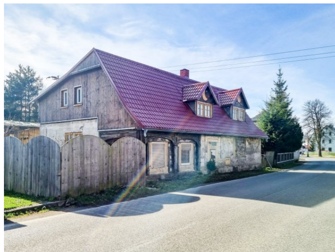
Mikulášovice č. p. 285 - Pohled na objekt ze severovýchodu (Zdroj: S. Šulcová, 2024)
