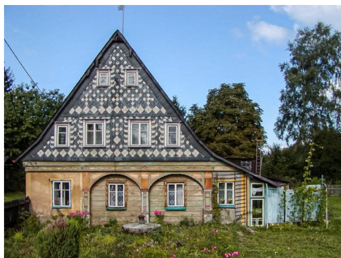
Mikulášovice č. p. 310 - Pohled na objekt z východu (Zdroj: TUR Šluknovsko, 2003)
