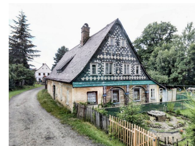
Mikulášovice č. p. 310 - Pohled na objekt (Zdroj: Mapy.cz, 2016)
