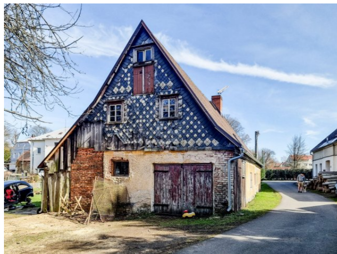
Mikulášovice č. p. 310 - Pohled na objekt ze západu (Zdroj: S. Šulcová, 2024)
