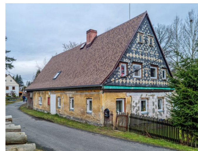
Mikulášovice č. p. 310 - Pohled na objekt z jihu (Zdroj: S. Šulcová, 2024)
