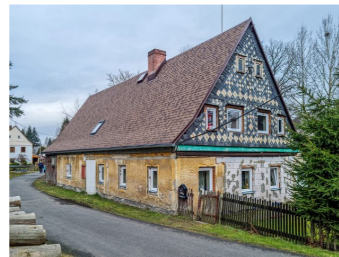
Mikulášovice č. p. 310 - Pohled na objekt z jihu (Zdroj: S. Šulcová, 2024)
