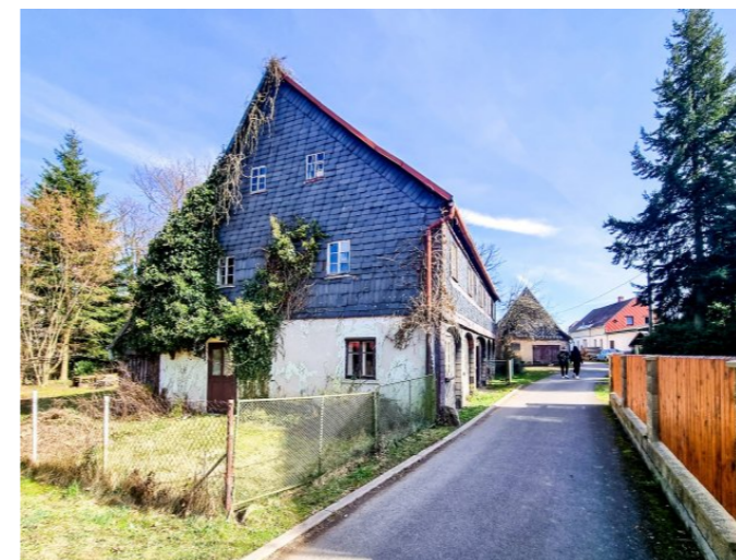
Mikulášovice č. p. 311 - Pohled na objekt ze západu (Zdroj: S. Šulcová, 2024)
