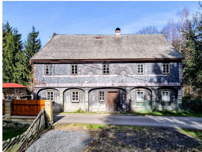
Mikulášovice č. p. 311 - Pohled na vstupní průčelí z jihozápadu (Zdroj: S. Šulcová, 2024)
