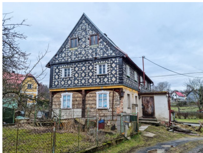
Mikulášovice č. p. 354 - Pohled na objekt ze severovýchodu (Zdroj: S. Šulcová, 2024)
