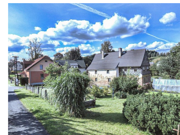
Mikulášovice č. p. 354 - Pohled na objekt z jihu (Zdroj: Mapy.cz, 2016)
