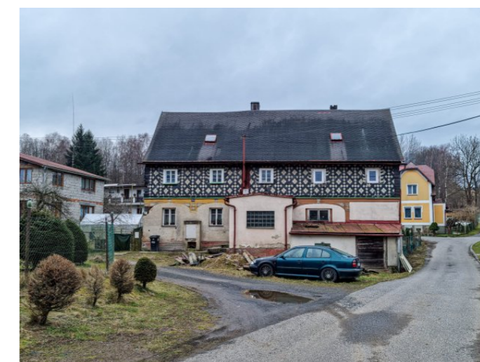
Mikulášovice č. p. 354 - Pohled na objekt ze severu (Zdroj: S. Šulcová, 2024)
