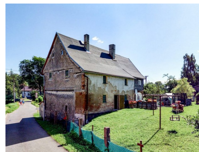
Mikulášovice č. p. 354 - Pohled na objekt z jihozápadu (Zdroj: Mapy.cz, 2021)
