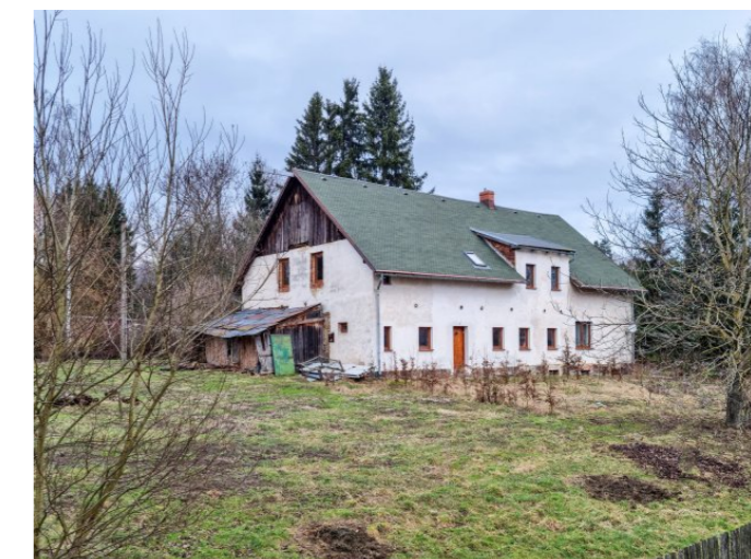
Mikulášovice č. p. 357 - Pohled na objekt z jihu (Zdroj: S. Šulcová, 2024)
