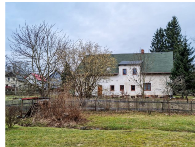
Mikulášovice č. p. 357 - Pohled na objekt z jihovýchodu (Zdroj: S. Šulcová, 2024)
