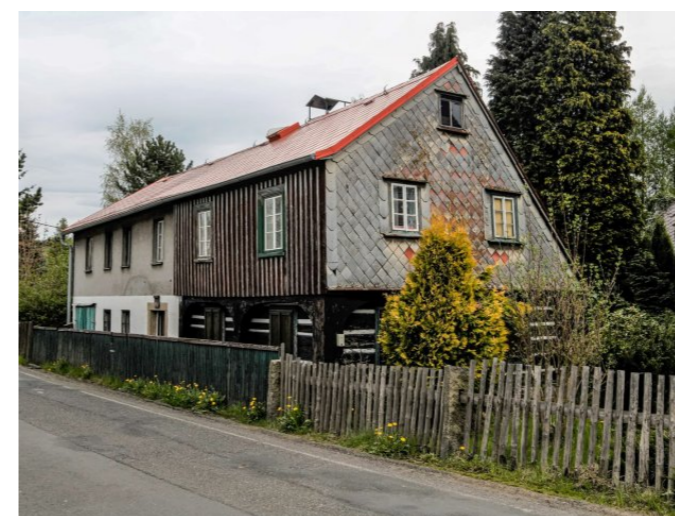
Mikulášovice č. p. 400 - Pohled na objekt z jihozápadu (Zdroj: S. Šulcová, 2017)
