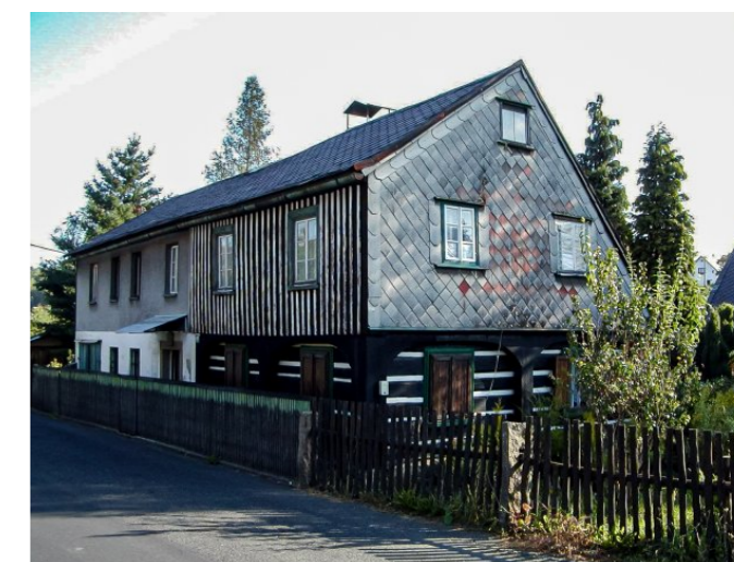
Mikulášovice č. p. 400 - Pohled na objekt z jihozápadu (Zdroj: TUR Šluknovsko, 2003)
