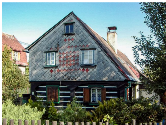
Mikulášovice č. p. 400 - Pohled na objekt z jihu (Zdroj: TUR Šluknovsko, 2003)
