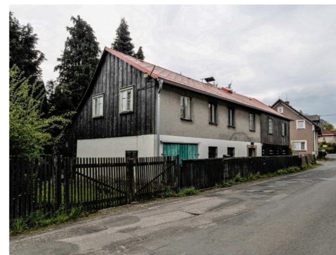
Mikulášovice č. p. 400 - Pohled na objekt ze severozápadu (Zdroj: S. Šulcová, 2017)
