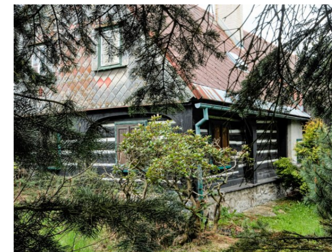
Mikulášovice č. p. 400 - Pohled na objekt z jihovýchodu (Zdroj: S. Šulcová, 2017)
