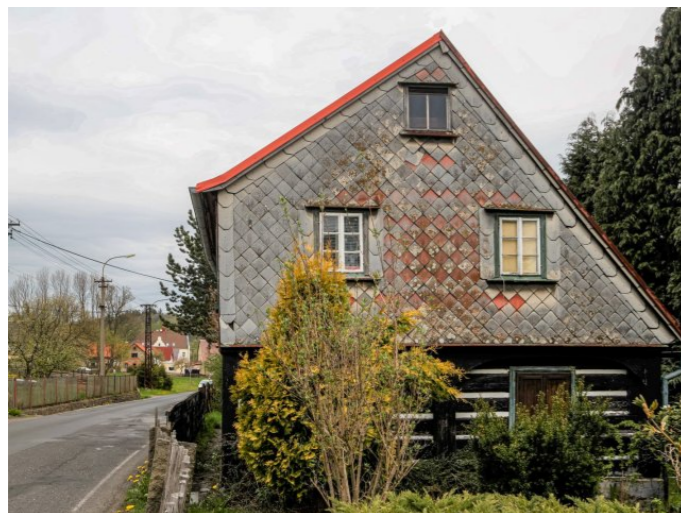
Mikulášovice č. p. 400 - Pohled na objekt z jihu (Zdroj: S. Šulcová, 2017)
