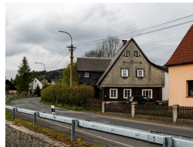
Mikulášovice č. p. 405 - Pohled na objekt ze severozápadu (Zdroj: S. Šulcová, 2017)
