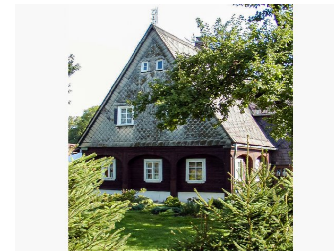
Mikulášovice č. p. 405 - Pohled na objekt z jihu (Zdroj: TUR Šluknovsko, 2003)
