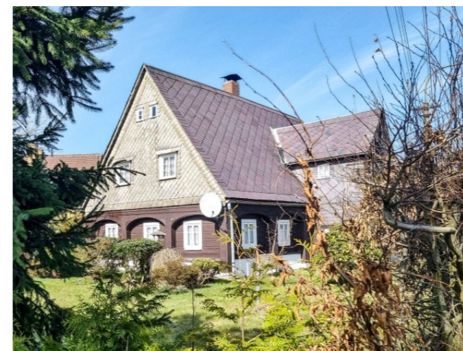
Mikulášovice č. p. 405 - Pohled na objekt z jihu (Zdroj: S. Šulcová, 2024)
