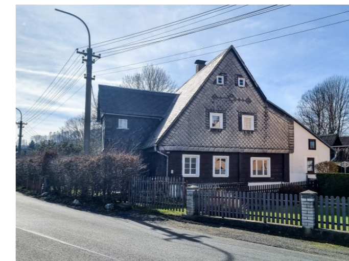
Mikulášovice č. p. 405 - Pohled na objekt ze severovýchodu (Zdroj: S. Šulcová, 2024)
