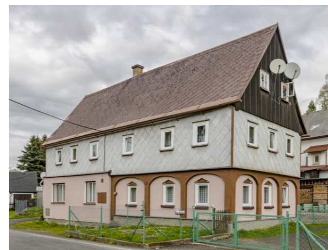
Mikulášovice č. p. 455 - Pohled na objekt z jihovýchodu (Zdroj: S. Šulcová, 2017)
