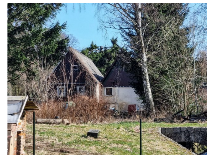
Mikulášovice č. p. 470 - Pohled na objekt ze západu (Zdroj: S. Šulcová, 2024)
