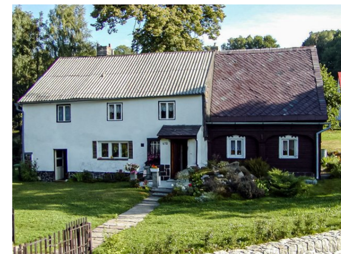
Mikulášovice č. p. 470 - Pohled na objekt z jihu (Zdroj: TUR Šluknovsko, 2003)
