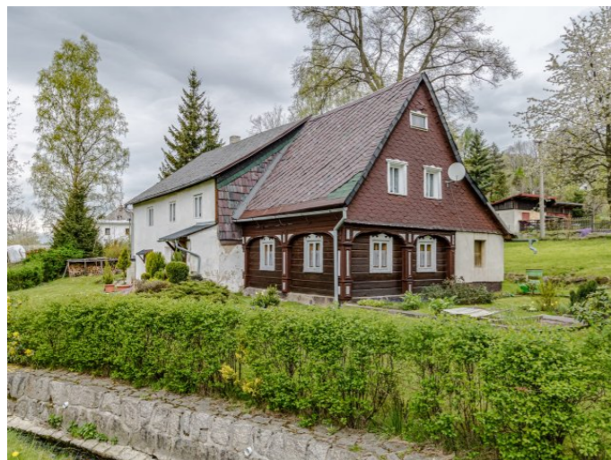
Mikulášovice č. p. 470 - Pohled na objekt z jihovýchodu (Zdroj: S. Šulcová, 2017)
