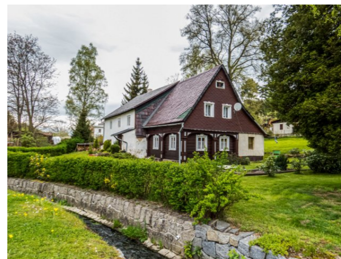
Mikulášovice č. p. 470 - Pohled na objekt z jihovýchodu (Zdroj: S. Šulcová, 2017)
