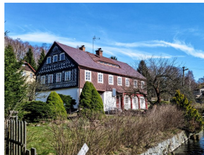
Mikulášovice č. p. 471 - Pohled na objekt z jihozápadu (Zdroj: S. Šulcová, 2024)
