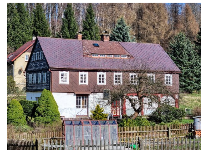
Mikulášovice č. p. 471 - Pohled na objekt z jihu (Zdroj: S. Šulcová, 2024)
