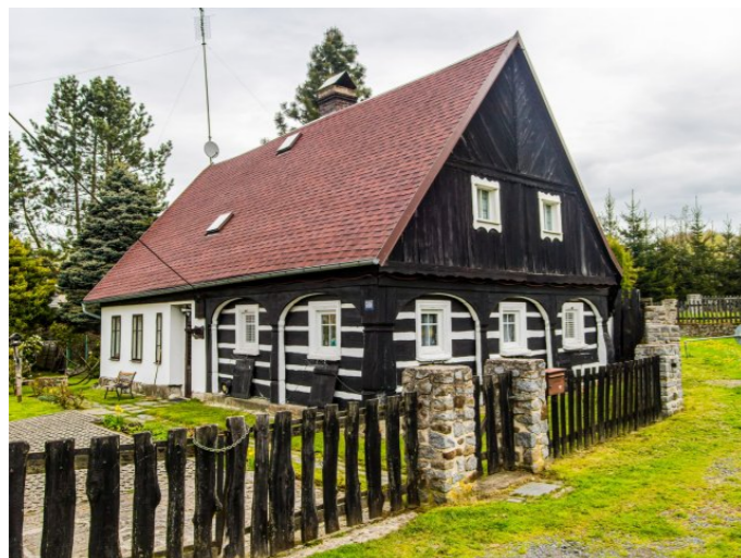
Mikulášovice č. p. 508 - Pohled na objekt z jihozápadu (Zdroj: S. Šulcová, 2017)
