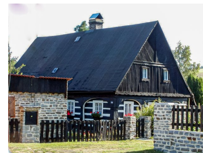
Mikulášovice č. p. 508 - Pohled na objekt z jihozápadu (Zdroj: TUR Šluknovsko, 2003)
