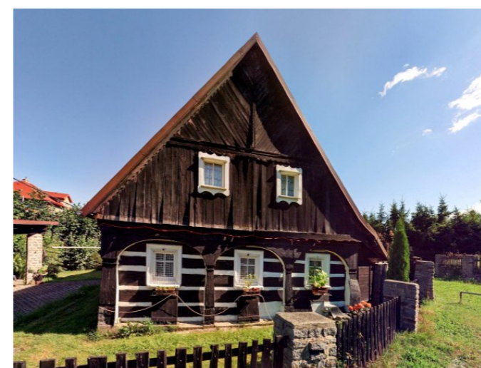
Mikulášovice č. p. 508 - Pohled na objekt z jihu (Zdroj: Mapy.cz, 2021)
