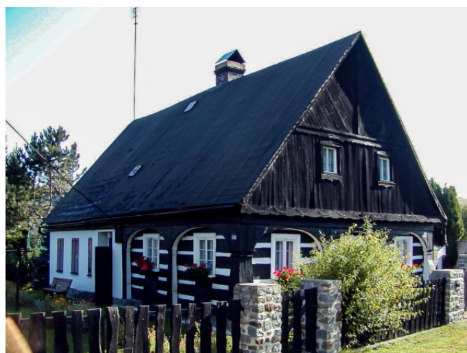
Mikulášovice č. p. 508 - Pohled na objekt z jihu (Zdroj: TUR Šluknovsko, 2003)
