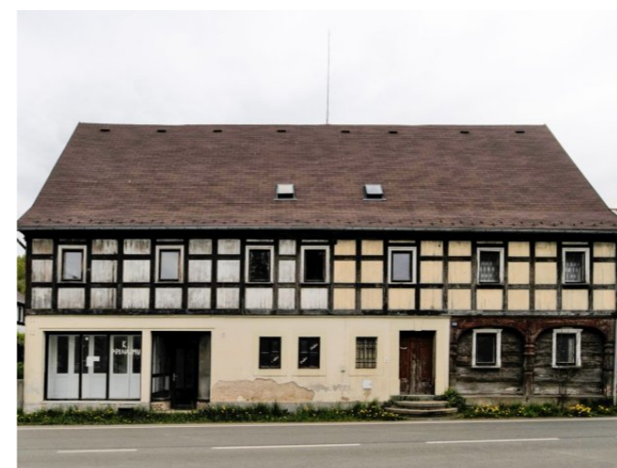
Mikulášovice č. p. 568 - Pohled na objekt ze západu (Zdroj: S. Šulcová, 2017)
