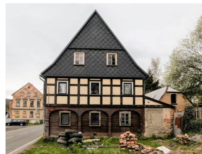
Mikulášovice č. p. 568 - Pohled na objekt z jihovýchodu (Zdroj: S. Šulcová, 2017)
