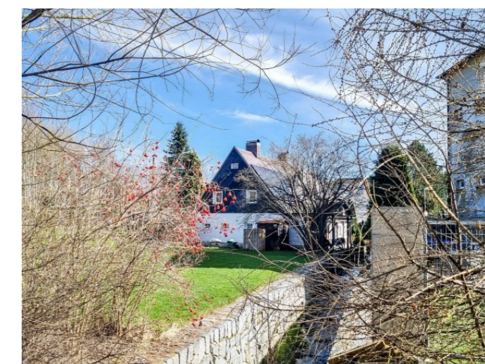
Mikulášovice č. p. 104 - Pohled na objekt ze severozápadu (Zdroj: S. Šulcová, 2024)
