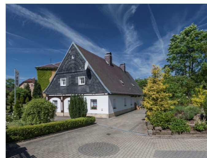
Mikulášovice č. p. 56 - Pohled na objekt z východu (Zdroj: S. Šulcová, 2017)
