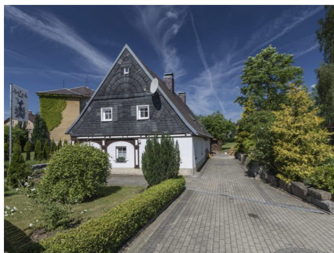
Mikulášovice č. p. 56 - Pohled na objekt z východu (Zdroj: S. Šulcová, 2017)
