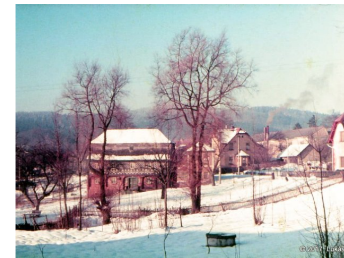
Mikulášovice č. p. 588 - Pohled na objekt z východu (Zdroj: Osobní archiv p. L. F. Fišera, 1980)
