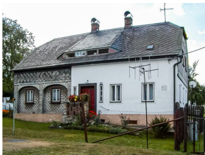
Mikulášovice č. p. 648 - Pohled na objekt ze severu (Zdroj: TUR Šluknovsko, 2003)
