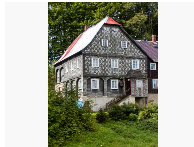
Mikulášovice č. ev. 15 - Pohled na objekt ze severovýchodu (Zdroj: TUR Šluknovsko, 2003)
