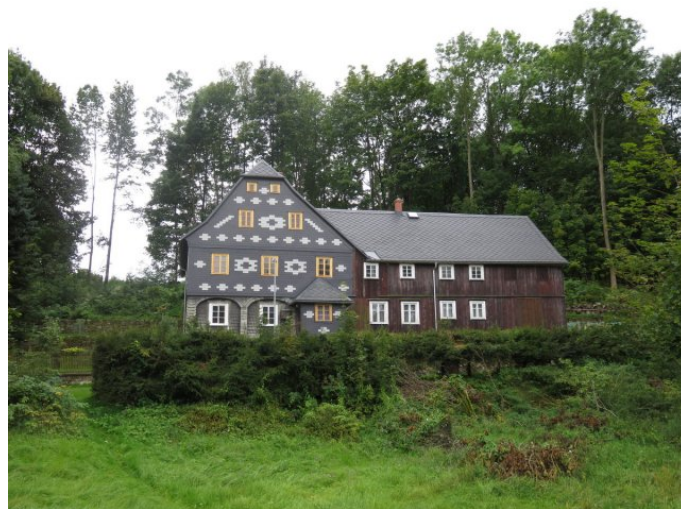
Mikulášovice č. ev. 15 - Pohled na objekt ze severu (Zdroj: S. Šulcová, 2017)
