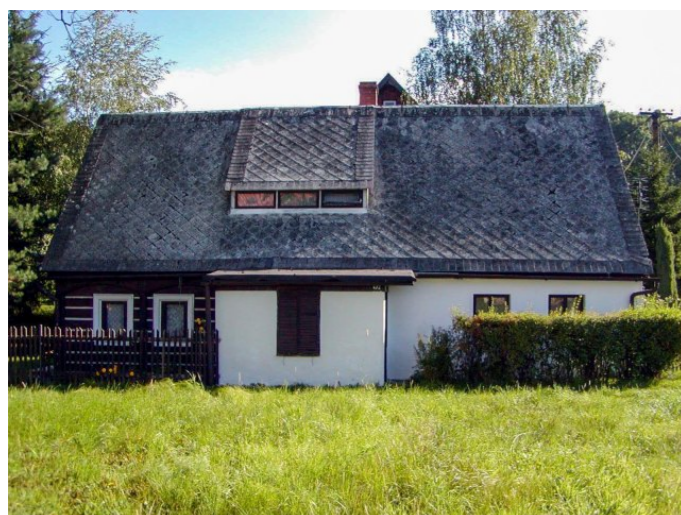
Mikulášovice č. ev. 5 - Pohled na objekt z jihozápadu (Zdroj: TUR Šluknovsko, 2003)
