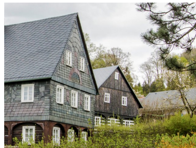
Mikulášovice č. ev. 9 - Detail na štítovou zeď (Zdroj: S. Šulcová, 2017)
