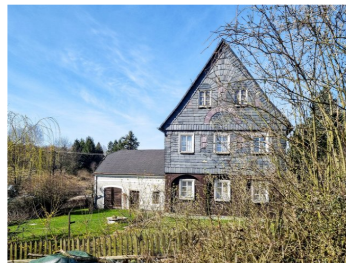
Mikulášovice č. ev. 9 - Pohled na objekt z jihovýchodu (Zdroj: S. Šulcová, 2024)
