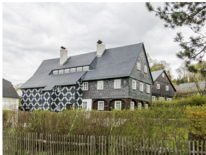
Mikulášovice č. ev. 9 - Pohled na objekt z jihu (Zdroj: S. Šulcová, 2017)
