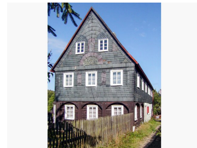
Mikulášovice č. ev. 9 - Pohled na objekt z jihovýchodu (Zdroj: TUR Šluknovsko, 2003)
