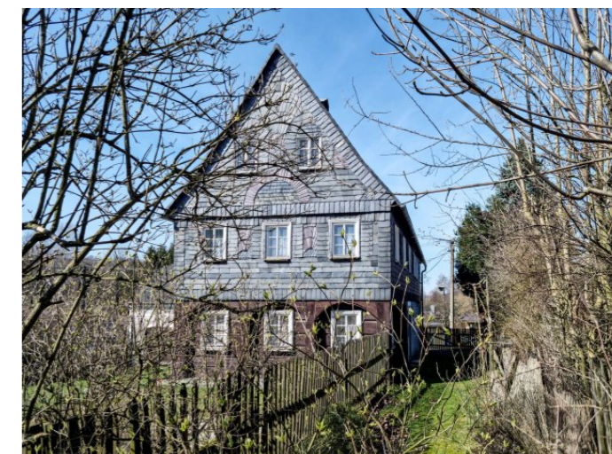
Mikulášovice č. ev. 9 - Pohled na objekt z jihovýchodu (Zdroj: S. Šulcová, 2024)
