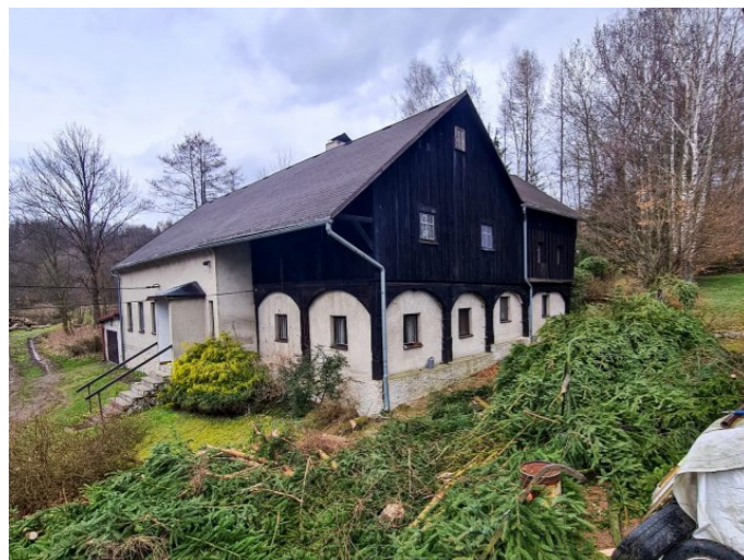
Mikulášovičky č. p. 3 - Pohled na objekt z jihu (Zdroj: S. Šulcová, 2023)
