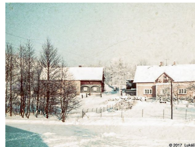
Mikulášovičky č. p. 3 - Pohled na objekt z jihozápadu (Zdroj: Osobní archiv p. L. F. Fišera, 1980)
