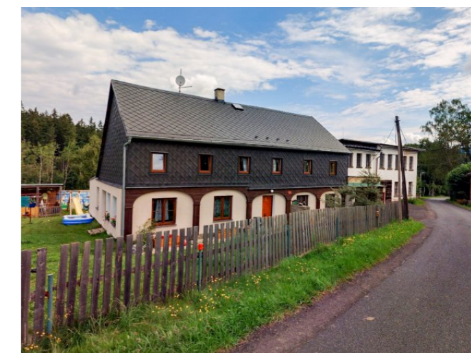
Salmov č. p. 12 - Pohled na objekt z jihozápadu (Zdroj: Mapy.cz, 2021)
