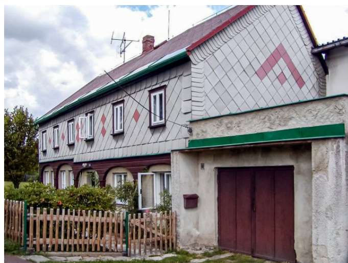
Salmov č. p. 12 - Pohled na objekt z jihovýchodu (Zdroj: TUR Šluknovsko, 2003)
