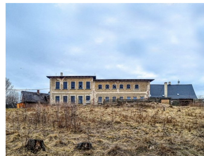
Salmov č. p. 12 - Pohled na objekt ze severu (Zdroj: S. Šulcová, 2022)
