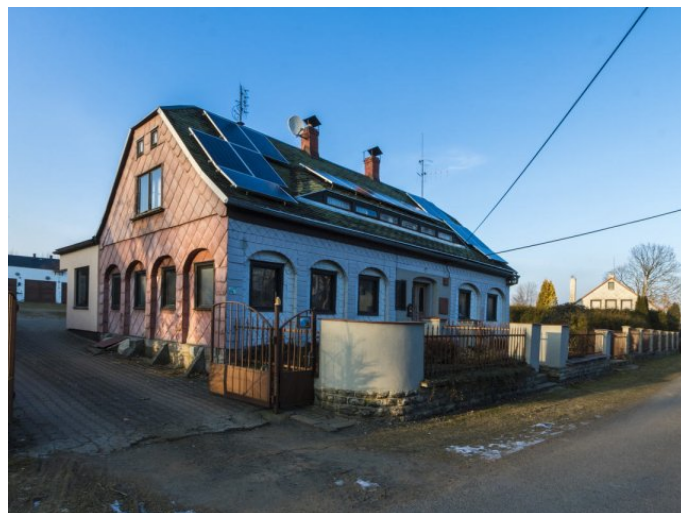
Staré Křečany č. p. 424 - Pohled na objekt (Zdroj: S. Šulcová, 2018)
