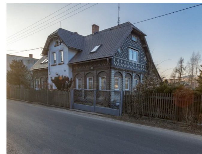
Staré Křečany č. p. 522 - Pohled na objekt (Zdroj: S. Šulcová, 2018)
