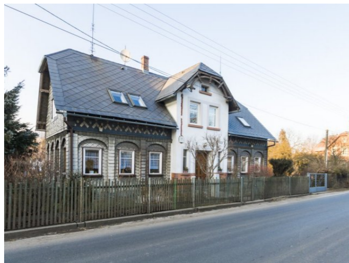
Staré Křečany č. p. 522 - Pohled na objekt (Zdroj: S. Šulcová, 2018)
