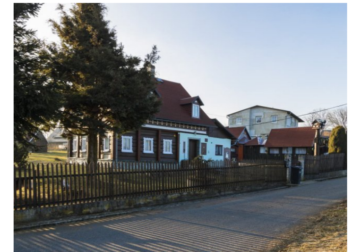
Staré Křečany č. ev. 35 - Pohled na objekt (Zdroj: S. Šulcová, 2018)
