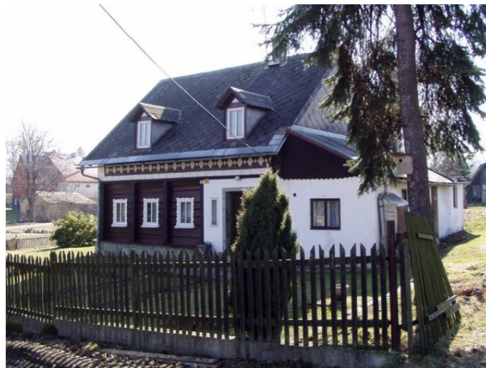
Staré Křečany č. ev. 35 - Pohled na objekt (Zdroj: TUR Šluknovsko, 2003)
