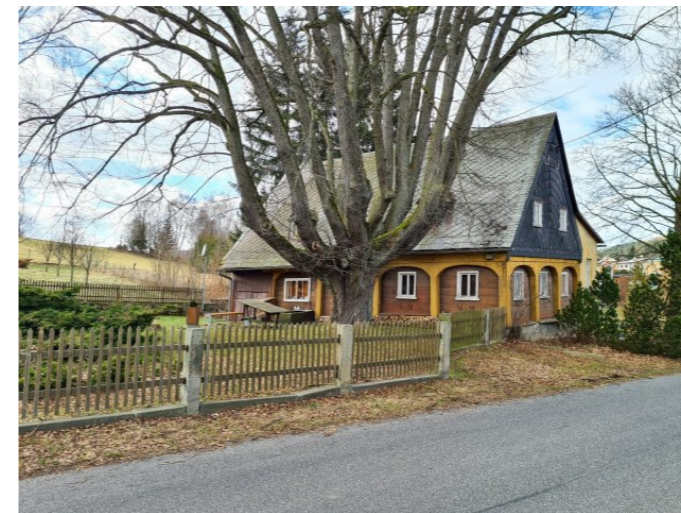
Vilémov č. p. 37 - Pohled na objekt z jihovýchodu (Zdroj: S. Šulcová, 2022)
