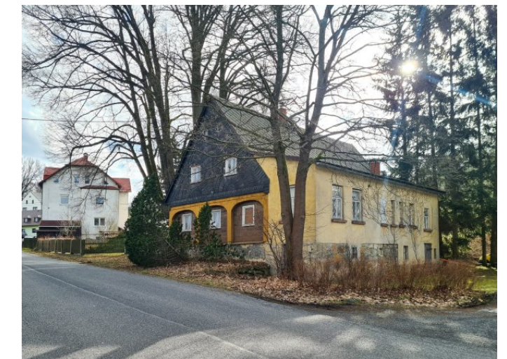
Vilémov č. p. 37 - Pohled na objekt ze severovýchodu (Zdroj: S. Šulcová, 2022)
