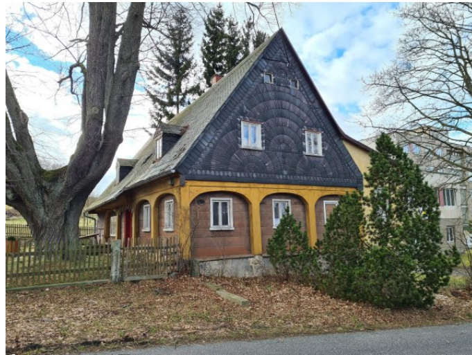
Vilémov č. p. 37 - Pohled na objekt z východu (Zdroj: S. Šulcová, 2022)
