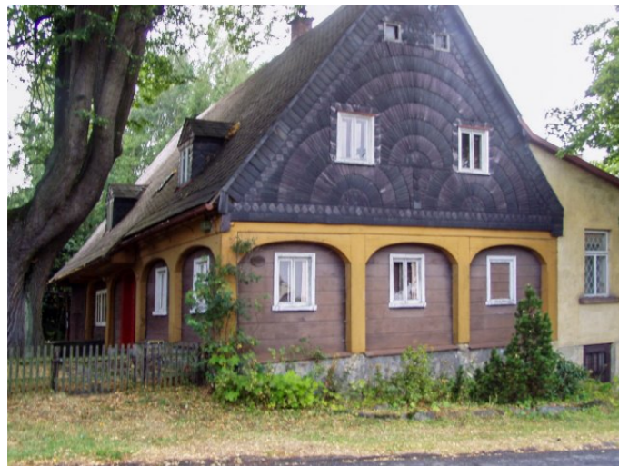
Vilémov č. p. 37 - Pohled na objekt z jihovýchodu (Zdroj: TUR Šluknovsko, 2003)
