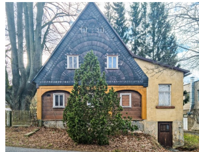
Vilémov č. p. 37 - Pohled na objekt z východu (Zdroj: S. Šulcová, 2022)
