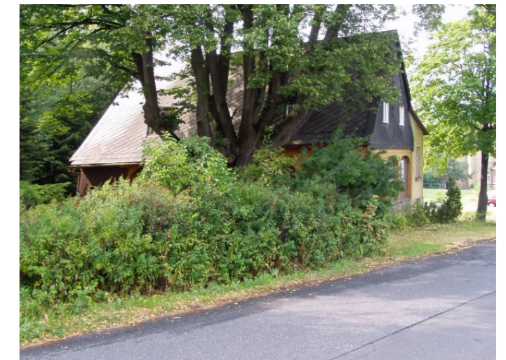
Vilémov č. p. 37 - Pohled na objekt z jihu (Zdroj: TUR Šluknovsko, 2003)
