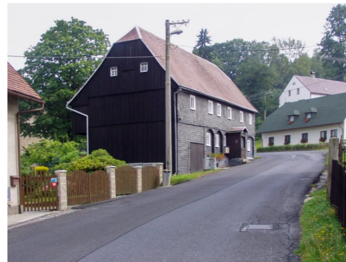
Vilémov č. p. 39 - Pohled na objekt ze severozápadu (Zdroj: TUR Šluknovsko, 2003)
