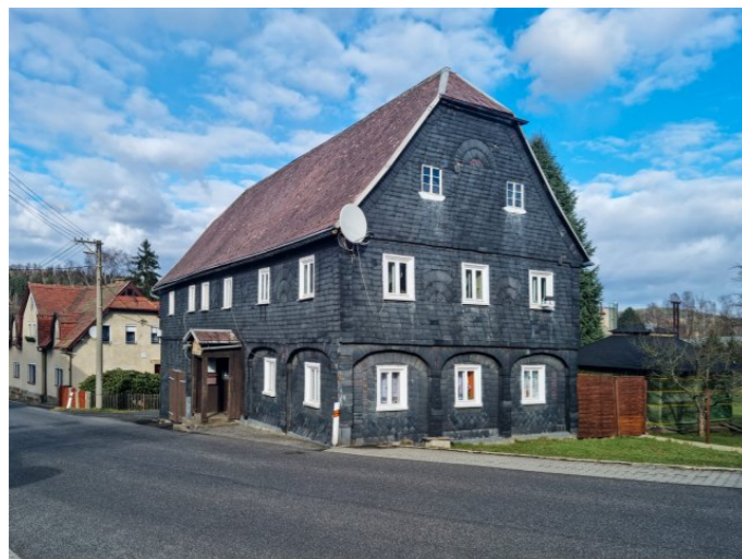
Vilémov č. p. 39 - Pohled na objekt z jihozápadu (Zdroj: S. Šulcová, 2022)
