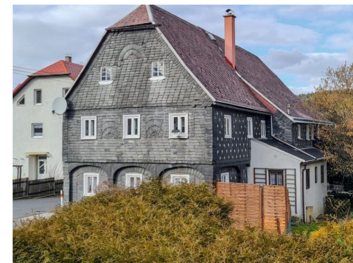
Vilémov č. p. 39 - Pohled na objekt z jihovýchodu (Zdroj: S. Šulcová, 2022)
