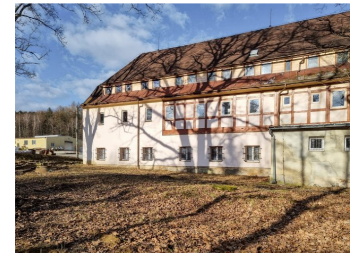
Vilémov č. p. 4 - Pohled na objekt z jihu (Zdroj: S. Šulcová, 2022)
