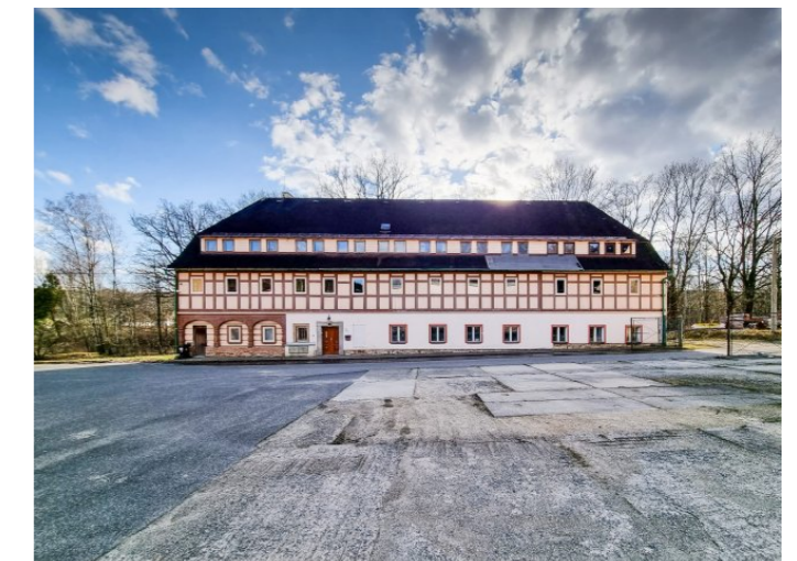
Vilémov č. p. 4 - Pohled na objekt ze severovýchodu (Zdroj: S. Šulcová, 2022)
