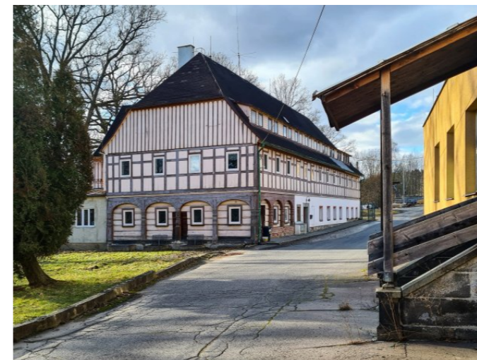
Vilémov č. p. 4 - Pohled na objekt z východu (Zdroj: S. Šulcová, 2022)
