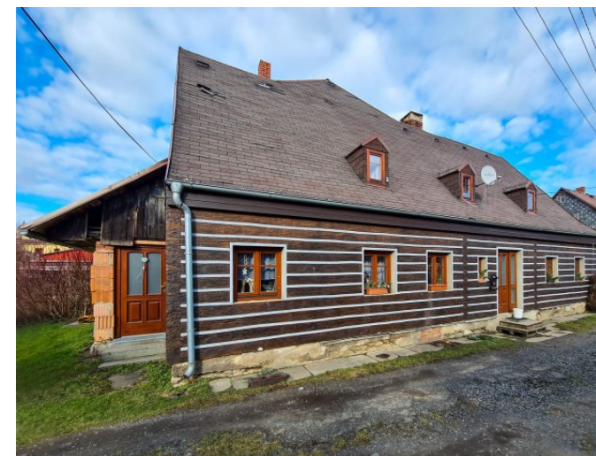
Vilémov č. p. 56 - Pohled na objekt z jihu (Zdroj: S. Šulcová, 2022)
