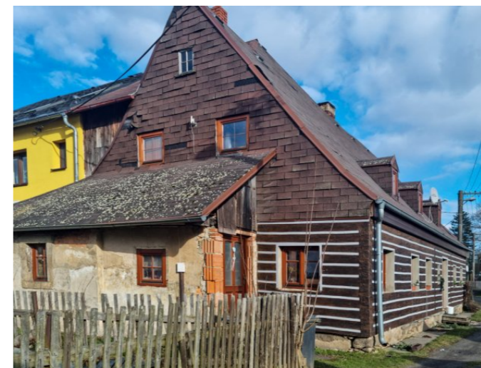
Vilémov č. p. 56 - Pohled na objekt ze západu (Zdroj: S. Šulcová, 2022)
