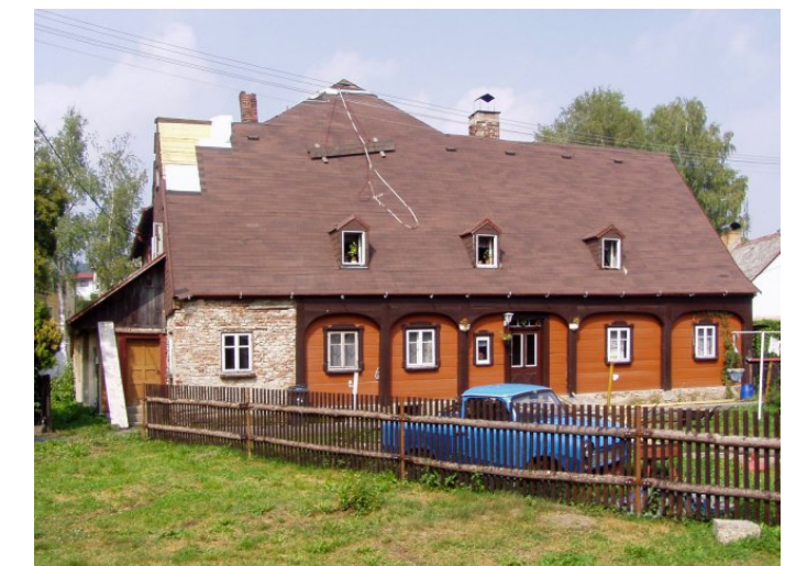
Vilémov č. p. 56 - Pohled na objekt z jihu (Zdroj: TUR Šluknovsko, 2003)
