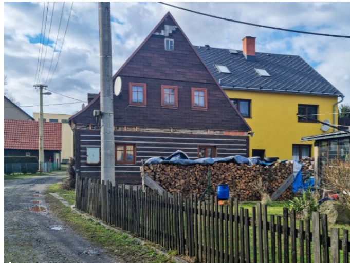
Vilémov č. p. 56 - Pohled na objekt z východu (Zdroj: S. Šulcová, 2022)
