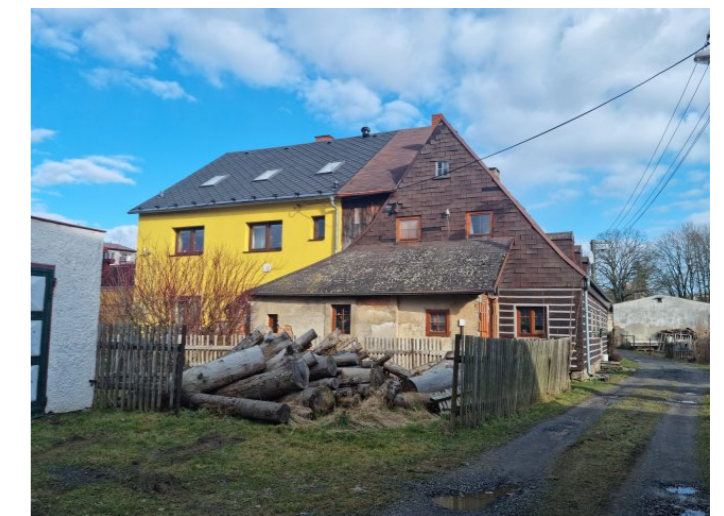
Vilémov č. p. 56 - Pohled na objekt ze západu (Zdroj: S. Šulcová, 2022)
