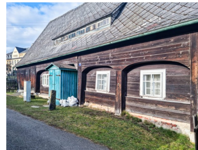
Vilémov č. p. 5 - Pohled na objekt z jihovýchodu (Zdroj: S. Šulcová, 2022)
