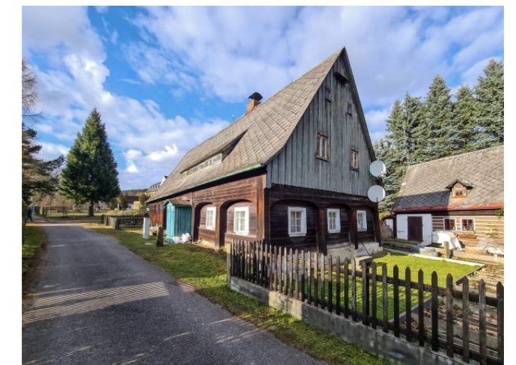
Vilémov č. p. 5 - Pohled na objekt z jihovýchodu (Zdroj: S. Šulcová, 2022)
