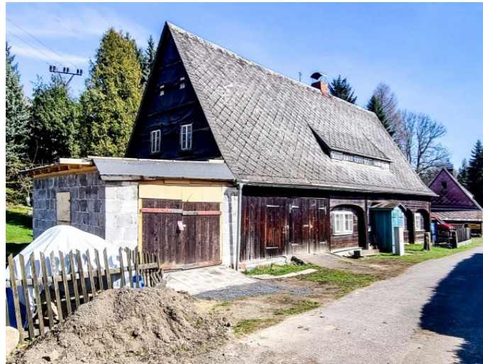
Vilémov č. p. 5 - Pohled na objekt z jihozápadu (Zdroj: S. Šulcová, 2024)
