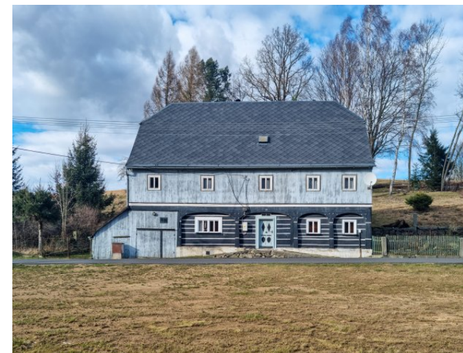
Vilémov č. p. 68 - Pohled na objekt z jihovýchodu (Zdroj: S. Šulcová, 2022)
