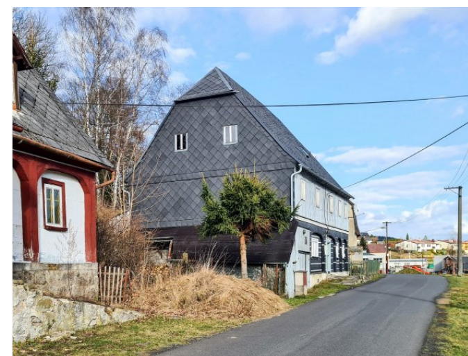
Vilémov č. p. 68 - Pohled na objekt z jihozápadu (Zdroj: S. Šulcová, 2022)
