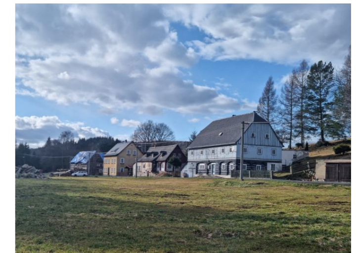
Vilémov č. p. 68 - Pohled na objekt z východu (Zdroj: S. Šulcová, 2022)
