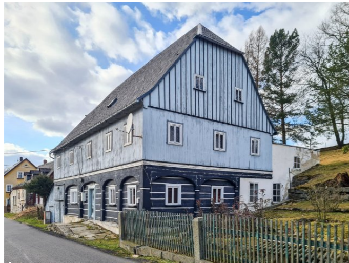
Vilémov č. p. 68 - Pohled na objekt z východu (Zdroj: S. Šulcová, 2022)
