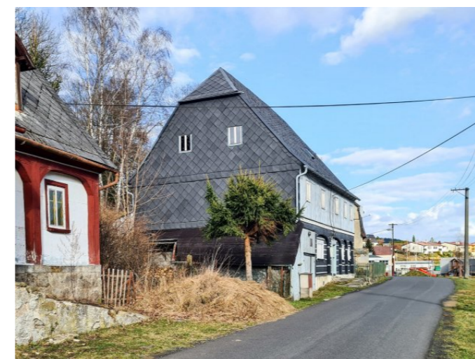
Vilémov č. p. 68 - Pohled na objekt z jihozápadu (Zdroj: S. Šulcová, 2022)
