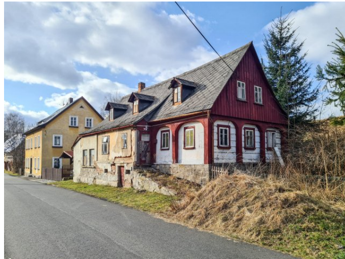
Vilémov č. p. 69 - Pohled na objekt z východu (Zdroj: S. Šulcová, 2022)
