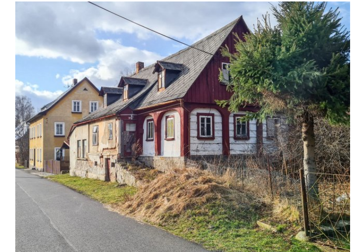
Vilémov č. p. 69 - Pohled na objekt z východu (Zdroj: S. Šulcová, 2022)
