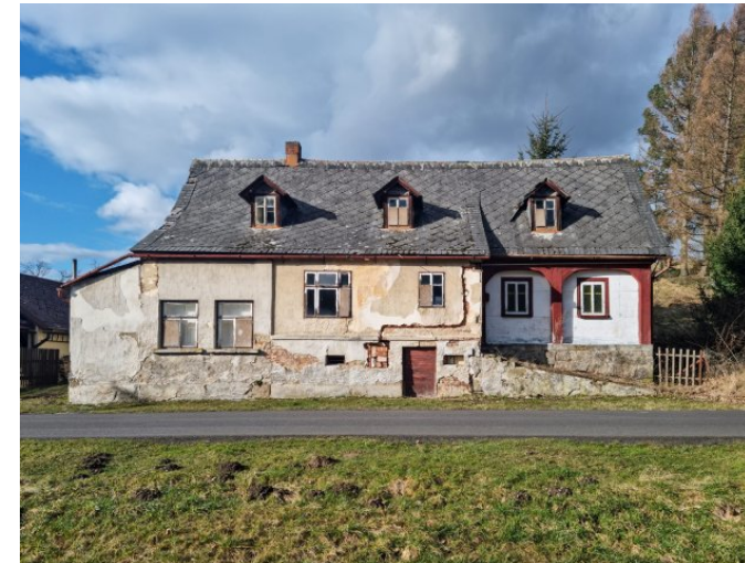
Vilémov č. p. 69 - Pohled na objekt z jihu (Zdroj: S. Šulcová, 2022)
