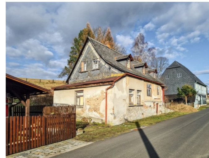
Vilémov č. p. 69 - Pohled na objekt z jihozápadu (Zdroj: S. Šulcová, 2022)
