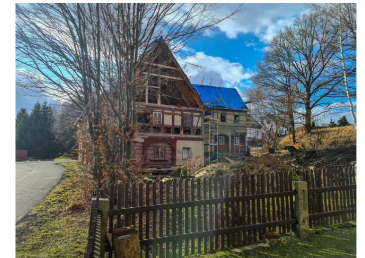
Vilémov č. p. 71 - Pohled na objekt z východu (Zdroj: S. Šulcová, 2022)
