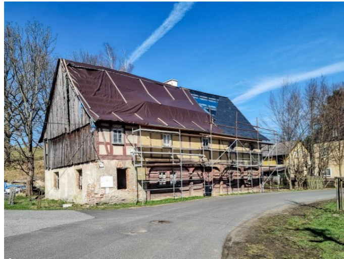
Vilémov č. p. 71 - Pohled na objekt z jihu (Zdroj: S. Šulcová, 2024)
