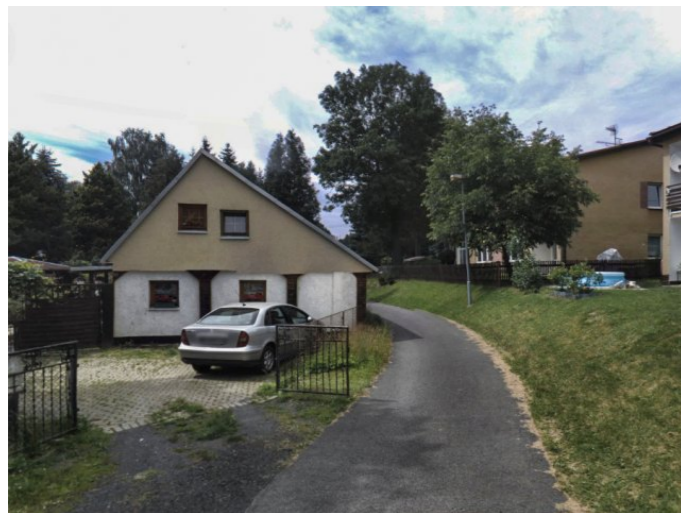
Vilémov č. p. 9 - Pohled na objekt z východu (Zdroj: Panorama - MAPY.CZ. (2016). [Vilémov 9]. Online. Seznam.cz, 2024. Dostupné z: https://mapy.cz/zakladni?pano=1&q=Vil%C3%A9mov%209 [citováno 2024-03-20], 2016)
